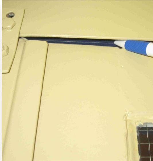
**Abbildung 15: Abschnittstür mit Spalt**
