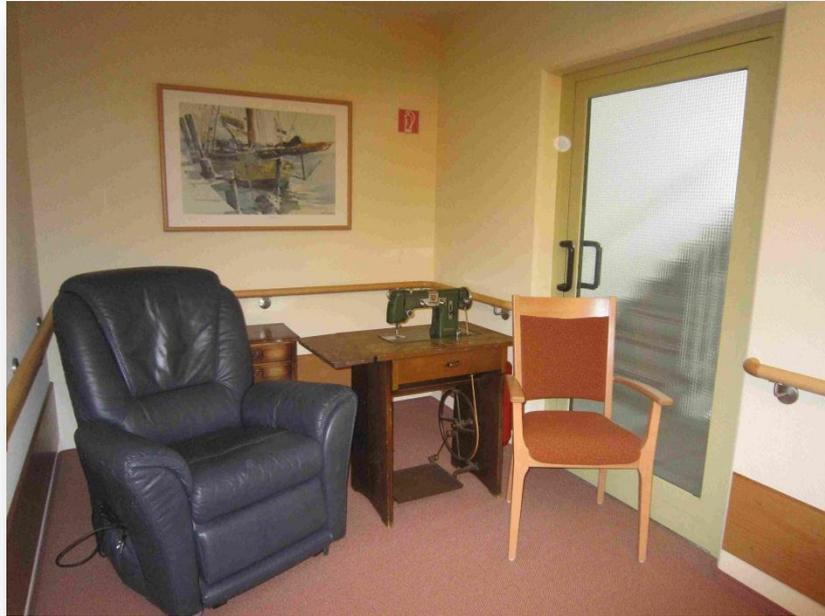
**Abbildung 16: Zugestellter Notausgang mit Stuhl, Brandlast durch Polstersessel**
