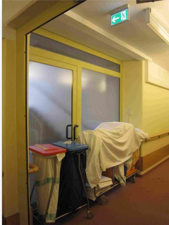
Abbildung 17: Zugestellter Notausgang durch Wäschewagen
