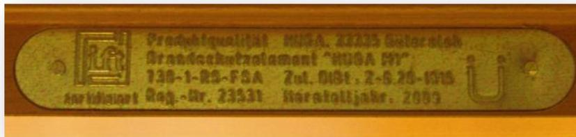
Abbildung 9: Kennzeichnungsschild einer T 30-RS Tür
